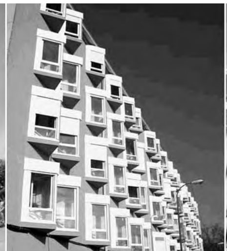
Bloque rehabilitado. Fachada oeste.
